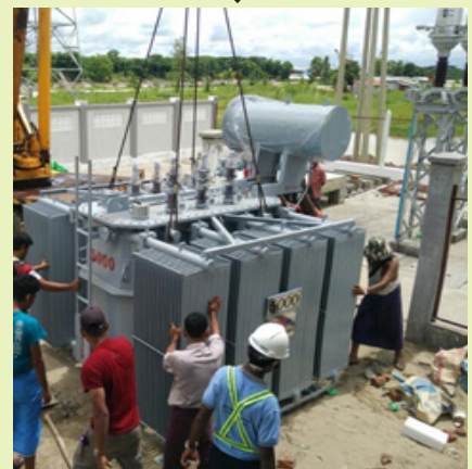
5 MVA Transformer တပ်ဆင်ခြင်း
